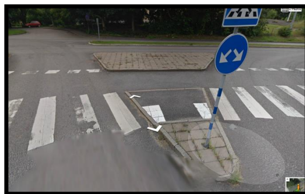
Bild 1. Bildexempel på problematiken kring generaliseringsregler i NVDB, där det i praktiken med refugen innebär att man måste åka två varv för att ploga bort all snö, vilket inte framgår av NVDB.
